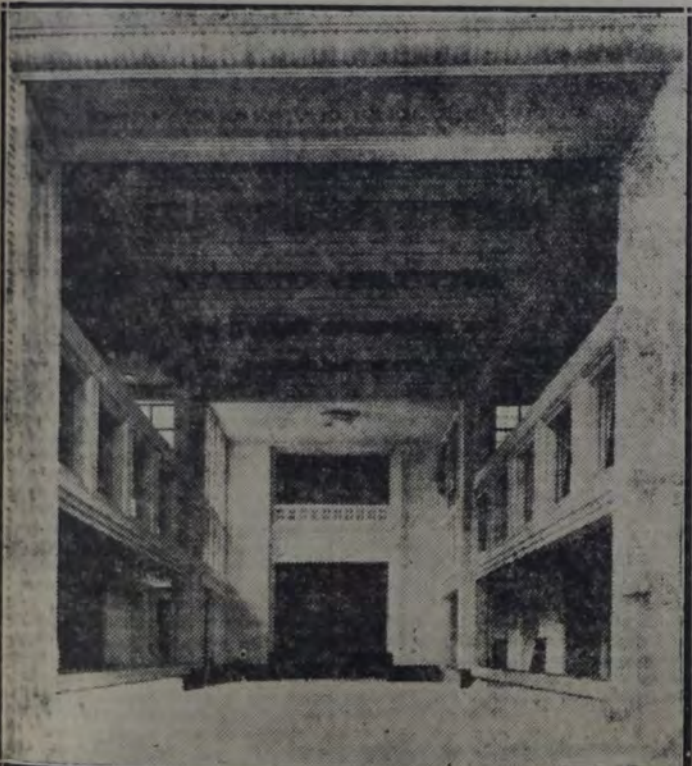
BANCO "EL HOGAR ARGENTINO" — ENTRADA POR LA CALLE FLORIDA
